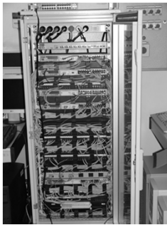
Komunikacijski ormarić s preklopnicama u koje se spajaju radne stanice (nalazi se u RC)
